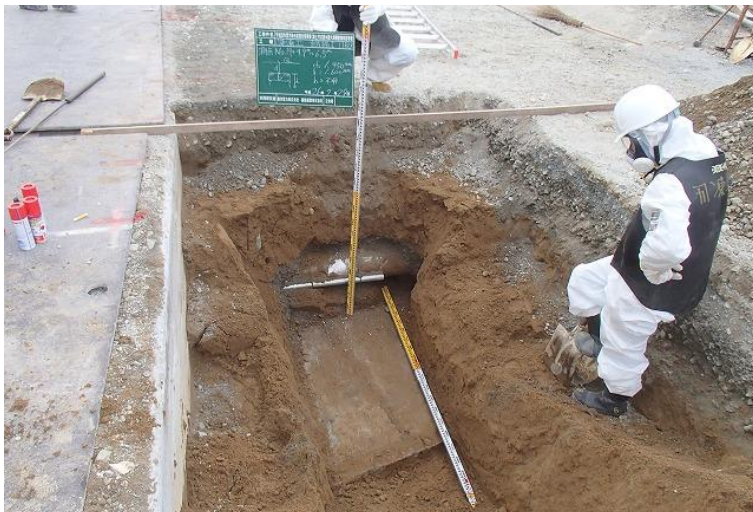
写真⑮ 1 1 BLK 埋設調査状況
