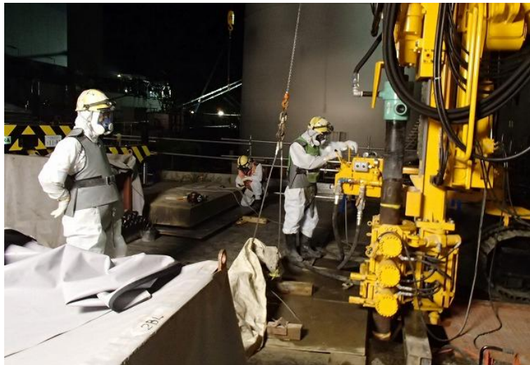
写真③ 2BLK 削孔状況
