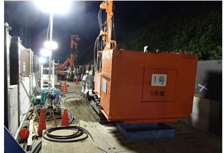
写真⑥ 5BLK 削孔状況
