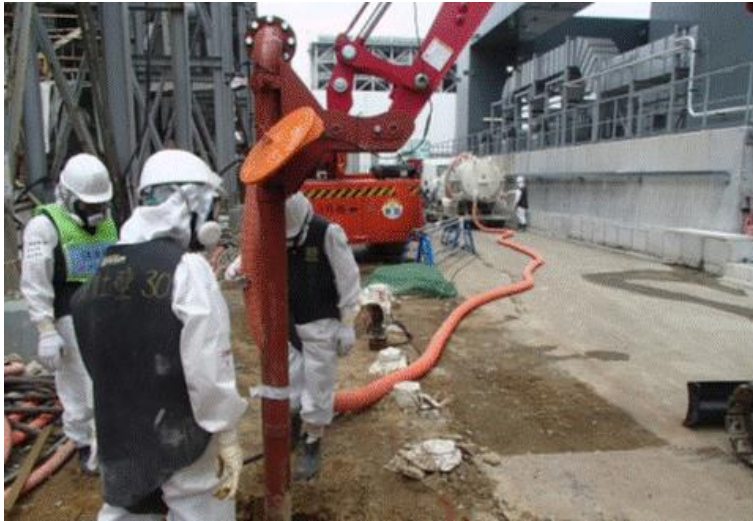
写真⑬ 8BLK 測温管試掘状況
