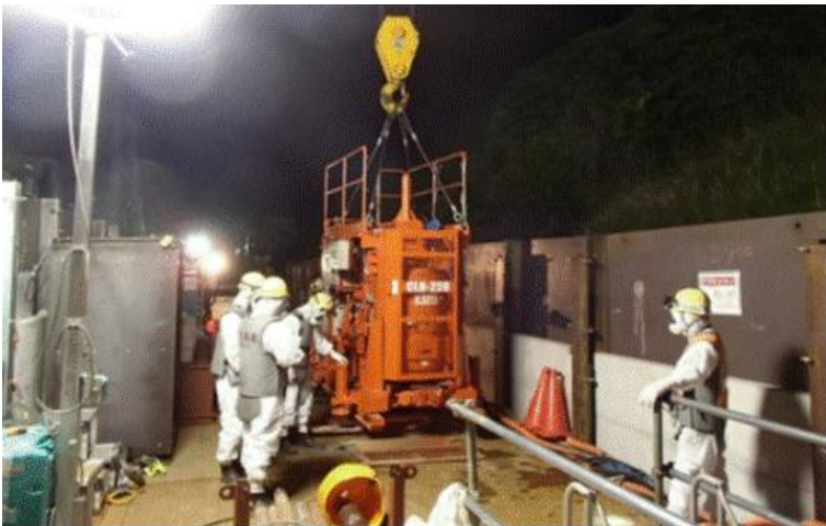
写真⑦ 5BLK 削孔状況
