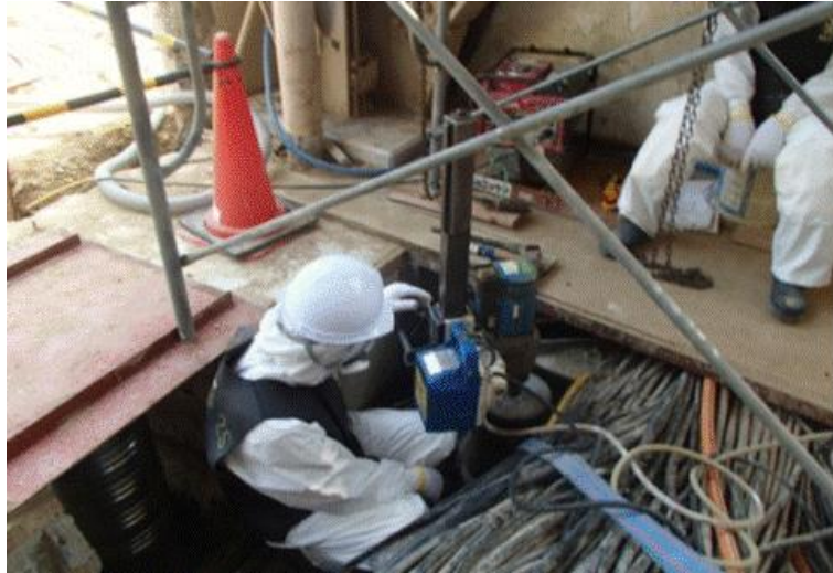
写真⑨ 6BLK コア削孔状況
