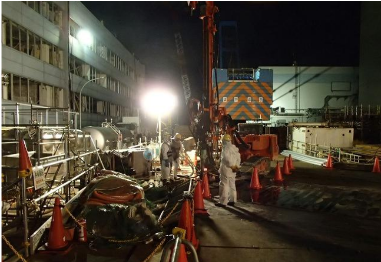
写真⑥ 4BLK 削孔状況
