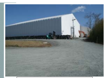
瓦礫保管テント
