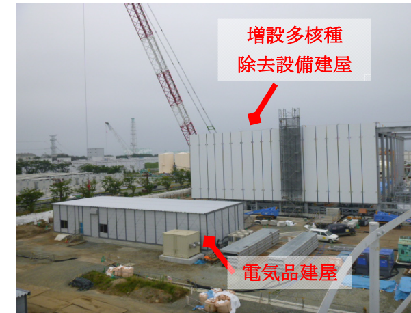
図3：増設多核種除去設備 全景
