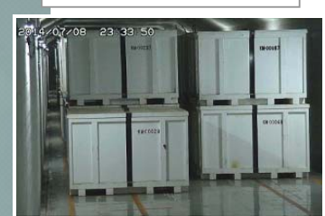
固体廃棄物貯蔵庫
