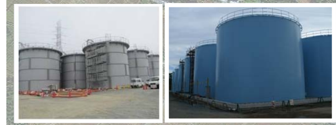
タンクの設置状況
