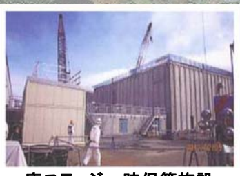
廃スラッジ一時保管施設
