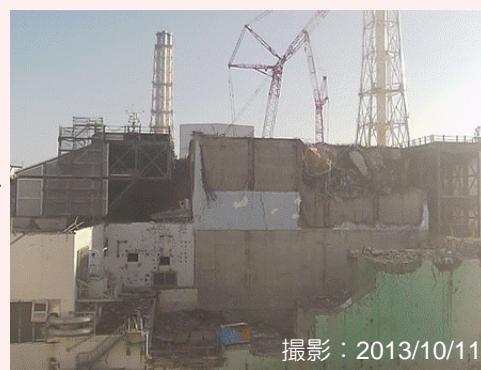
大型ガレキ撤去後
