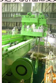
燃料取り出し状況
