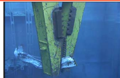
<使用済燃料プール内ガレキ撤去作業状況>
