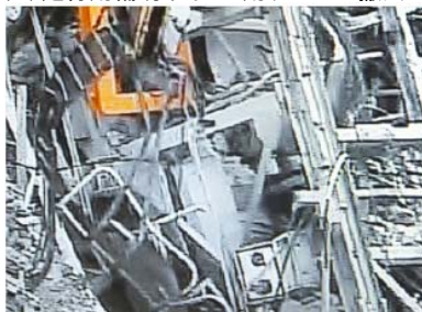
(4) 走行用補助ホイスト用ケーブル撤去
