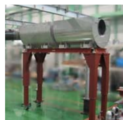
架台及び遮へい容器を組立て設置
