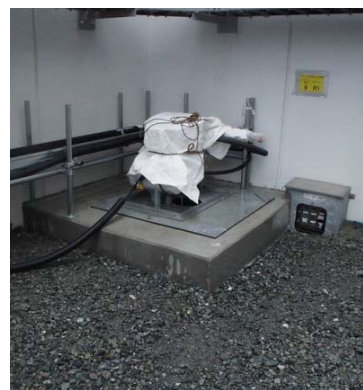
サブドレンピット
