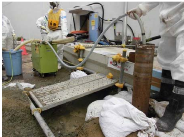
グラウト注入孔施工状況
