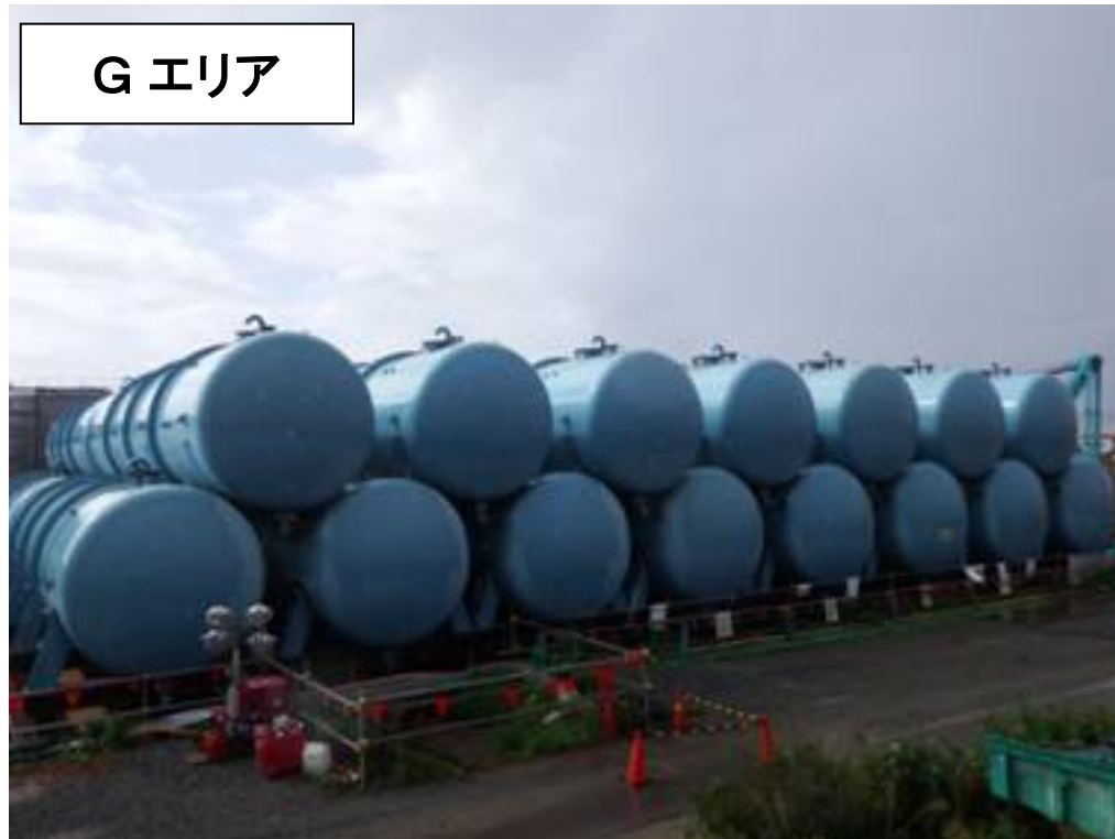
撤去タンク移設先の俵積み状況
