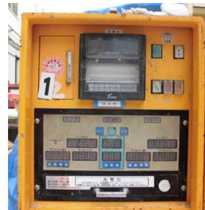
注入量・注入圧確認
