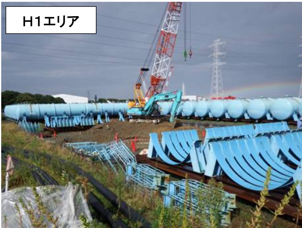
ブルータンク撤去中ヤード状況
