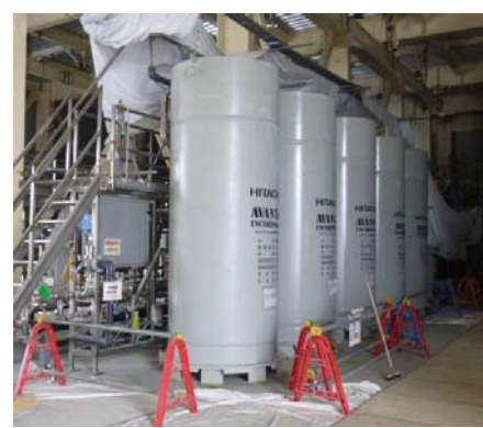
浄化設備 (吸着塔)
