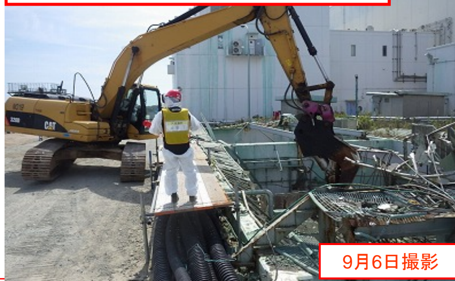
10m盤 逆洗弁ピット瓦礫撤去状況
