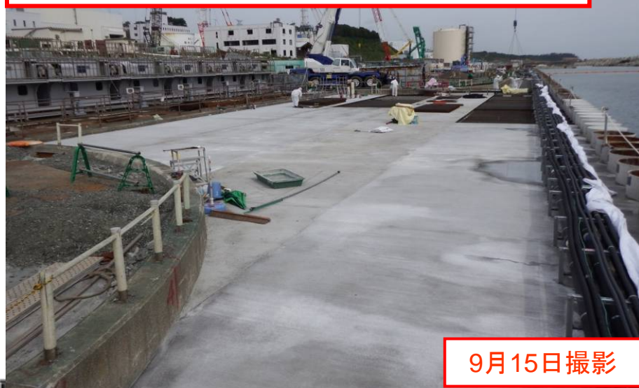
4m盤 コンクリート打設状況
