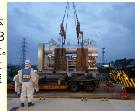
<凍結用冷凍機の設置作業>
