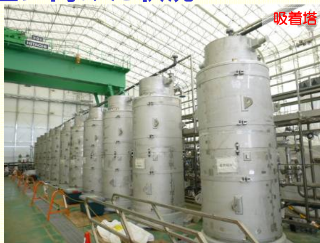
<高性能多核種除去設備 設置状況>
