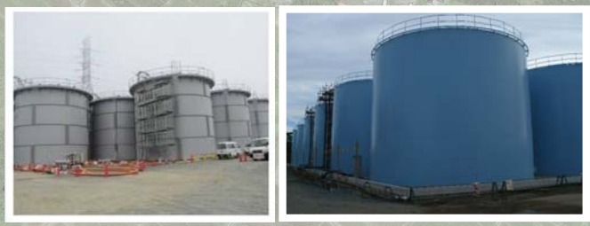
タンクの設置状況
