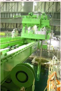
燃料取り出し状況
