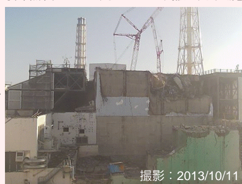
大型ガレキ撤去後
