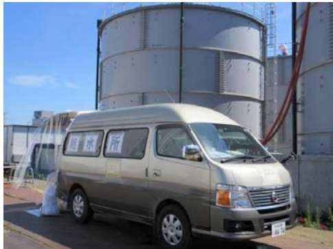
移動式給水所（多核種除去設備前）
