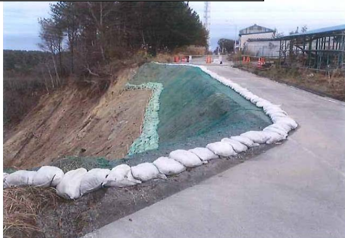
崩壊法肩部復旧状況 (補修当時)
