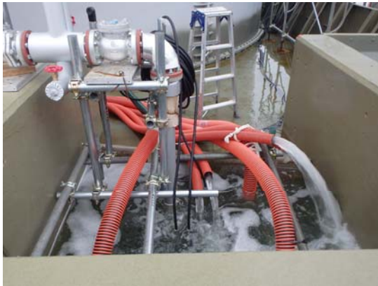
(ポンプピット)
