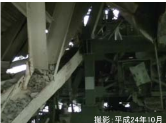
建屋カバー内の状況
