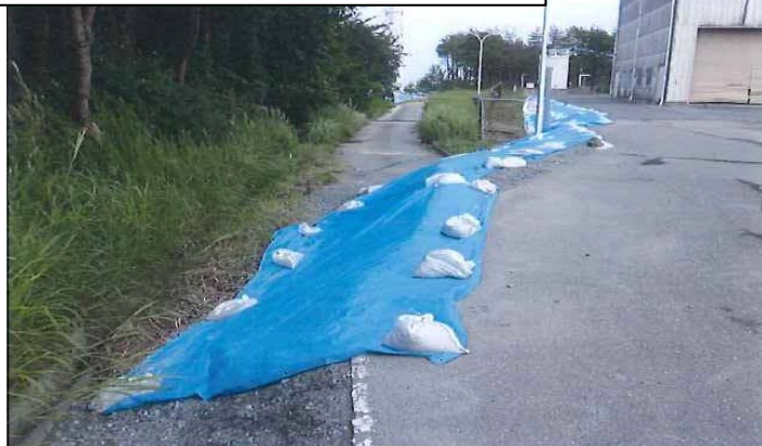
損傷路面補修状況 (補修当時)
