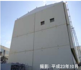
建屋カバーの設置状況
