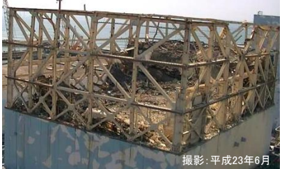
建屋カバー設置前の状況
