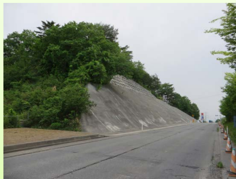
除草・堆積物除去 モルタル部は、高圧洗浄
