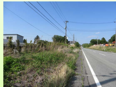
除草・堆積物除去、 表土の削り取り、土地表面の被覆
