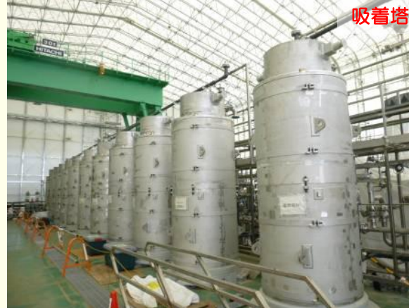
＜高性能多核種除去設備 設置状況＞
