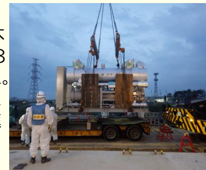
＜凍結用冷凍機の設置作業＞
