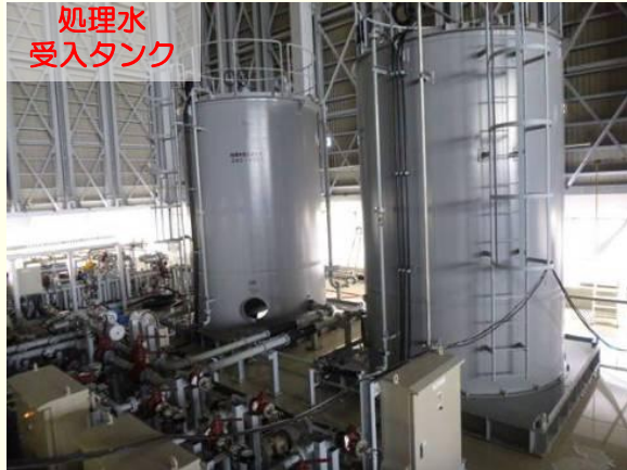
＜増設多核種除去設備 設置状況＞
