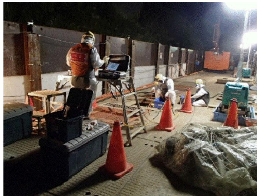
写真⑤-2 5BLK削孔傾斜測定
