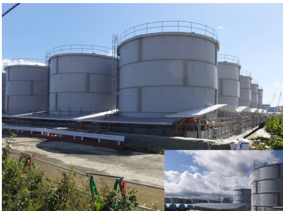
①H2南エリア 堰カバー設置完了
