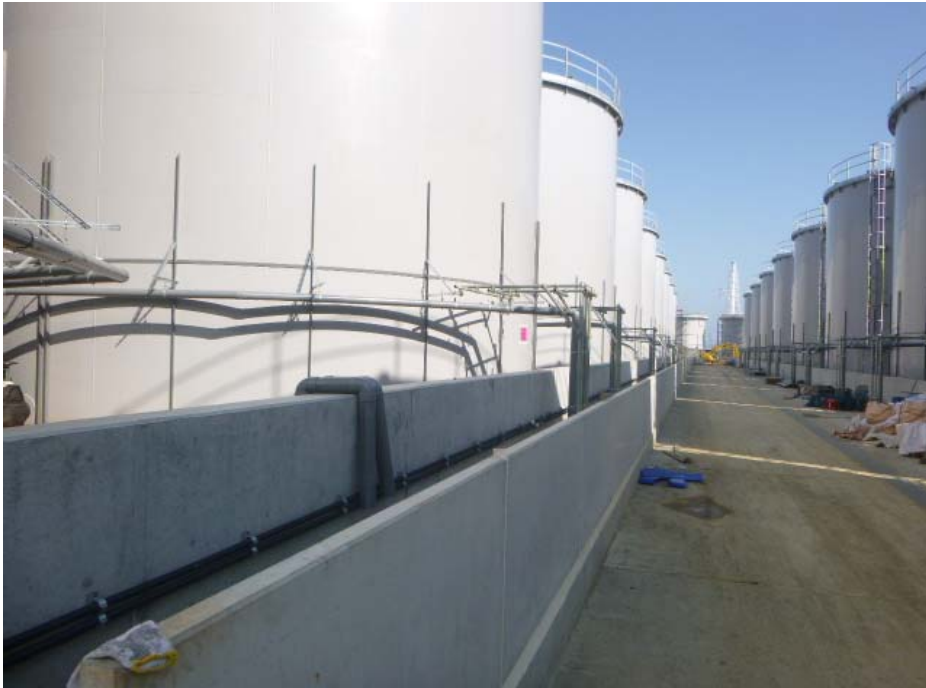
③J1(西)エリア 内堰設置完了
