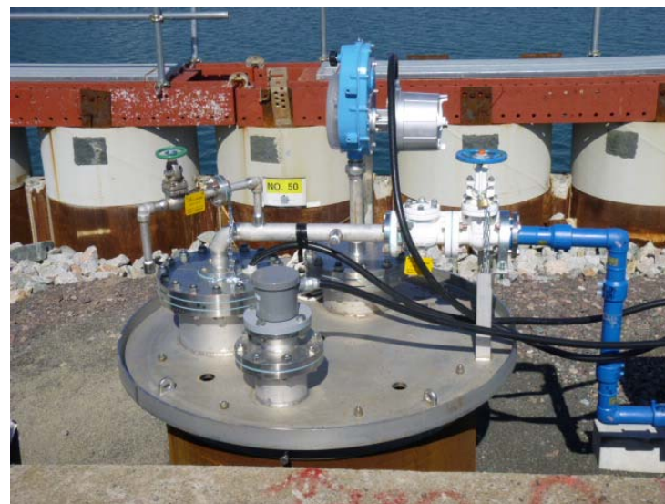
地下水ドレンポンド（A）
