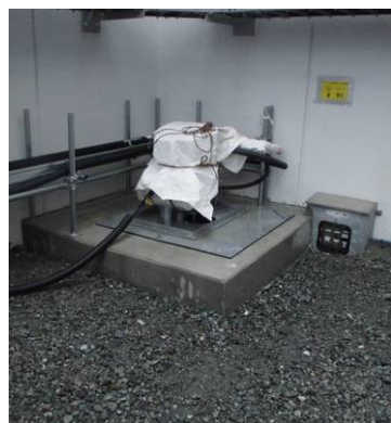
サブドレンピット
