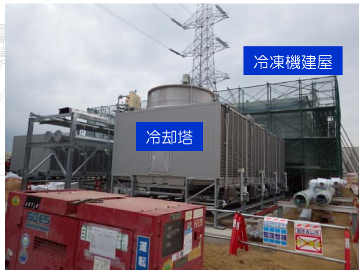
写真②：南側プラント冷却塔設置状況
