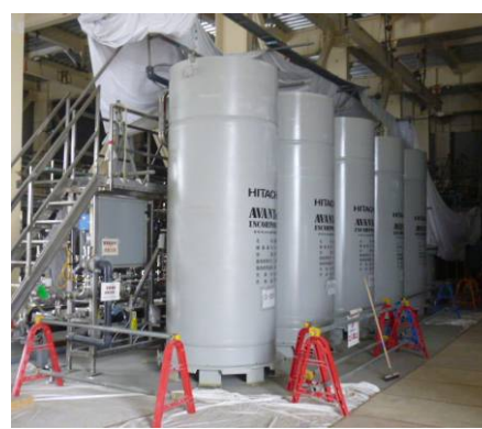
浄化設備 (吸着塔)
