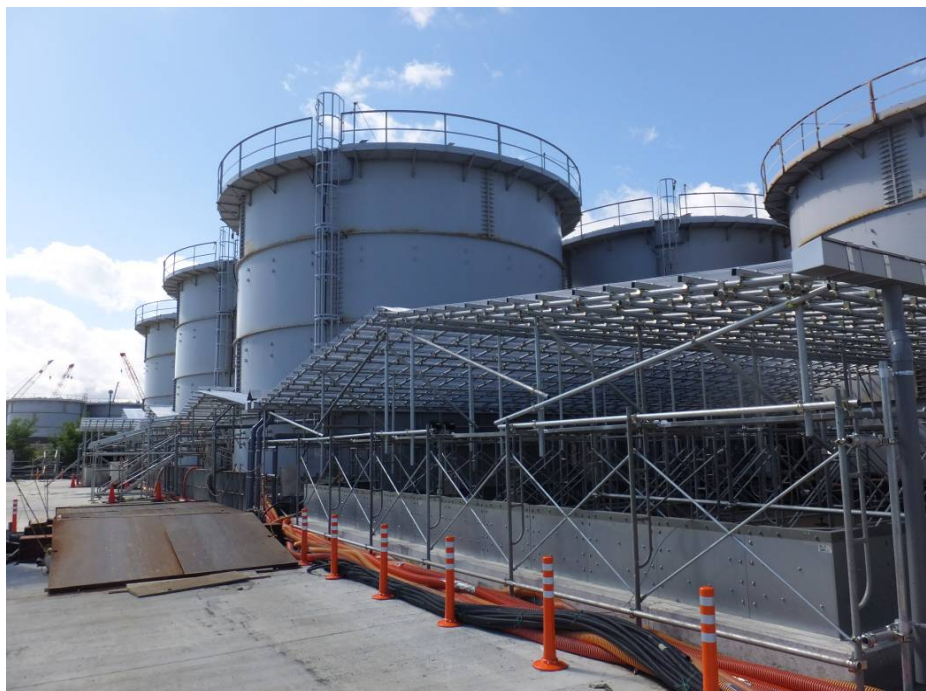
①H2南エリア 堰カバー設置完了
