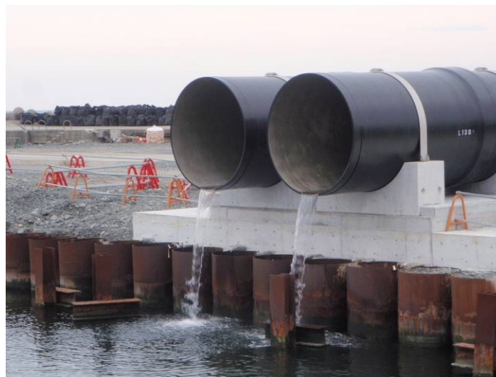
本設の排水口
