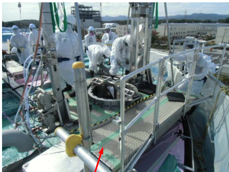
天板上に作業用プラットフォーム設置
