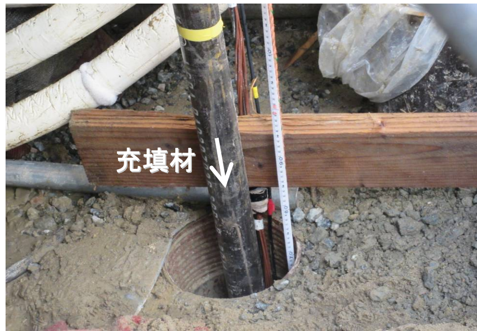
充填孔 (K 1 孔) 付近の様子
