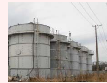
堰カバー設置前
