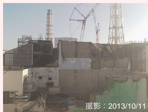
大型ガレキ撤去後
