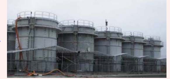
堰カバー設置後
