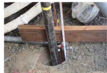
充填孔付近の様子
