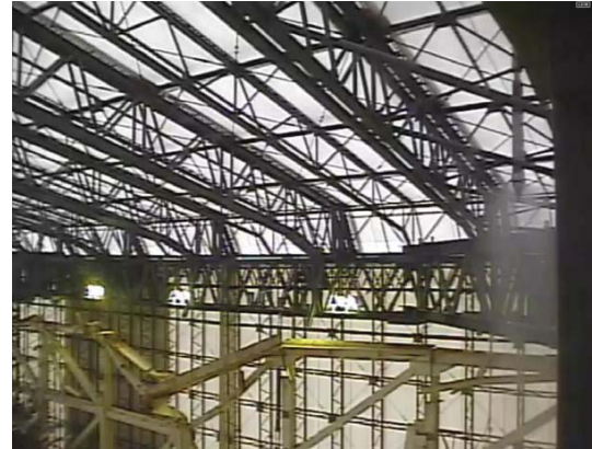
建屋カバー内（散布中の様子） [散布装置]
