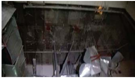
写真①：4階 南西部天井
