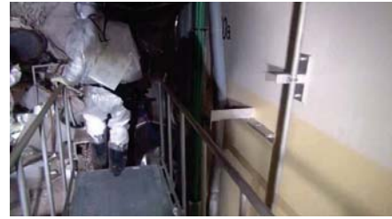
写真④：4階 使用済燃料プール壁
