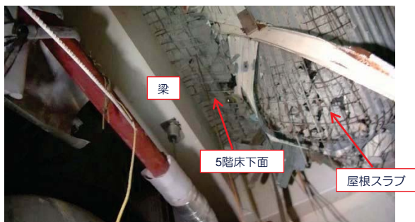
写真①：4階 天井
