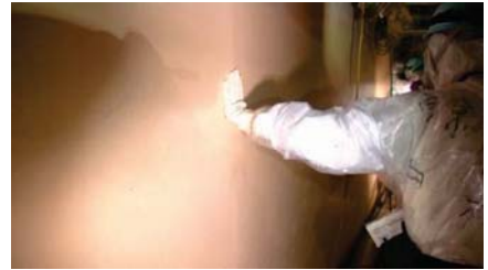
写真⑤：3階 使用済燃料プール壁
