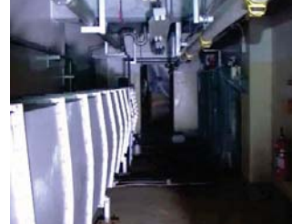
写真⑥：3階 東側通路天井および外壁
