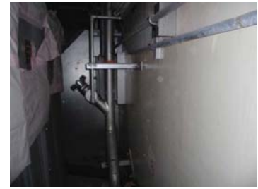
④ 西面（内壁）
