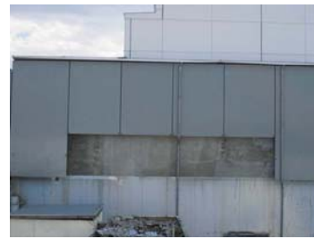
⑤ 西面（外壁）
