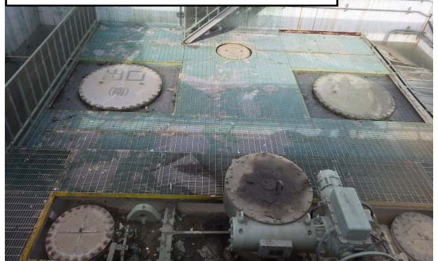
逆洗弁ピット(3号)内瓦礫撤去完了
