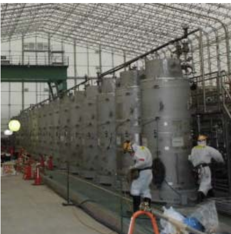
高性能多核種除去設備吸着塔
