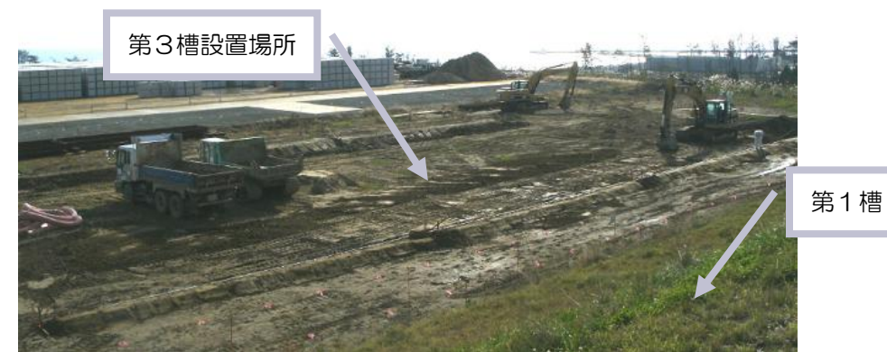
図11：覆土式一時保管施設 第3槽設置エリアの掘削状況
