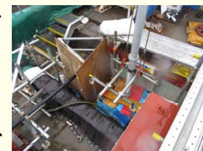
<充填孔付近の様子>
