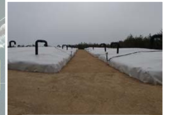
伐採木一時保管槽
