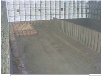
瓦礫保管 テント内
