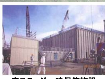
廃スラッジ一時保管施設
