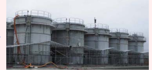
堰カバー設置後
