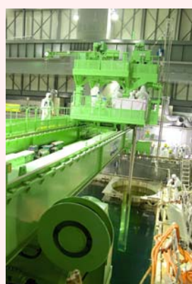
燃料取り出し状況
