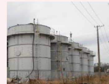
堰カバー設置前
