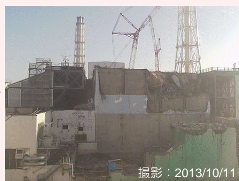
大型ガレキ撤去後
