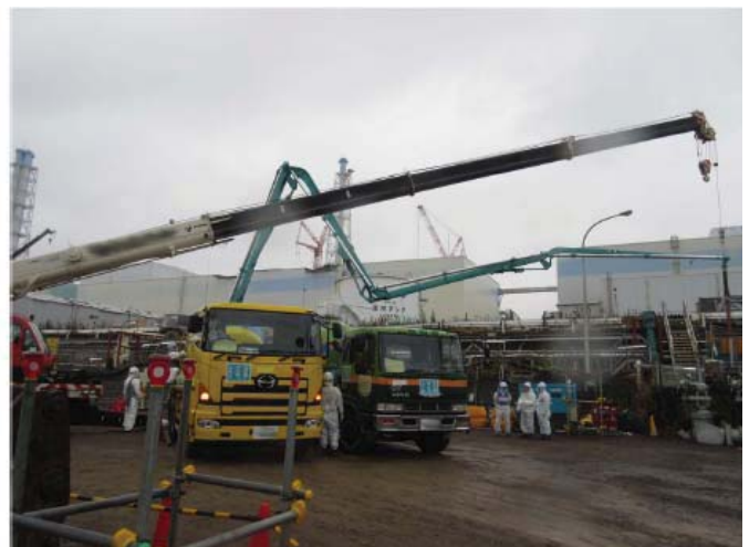
充填作業状況
