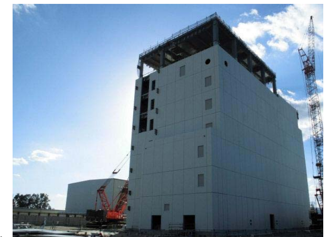
大型休憩所建設状況 平成26年11月時点
