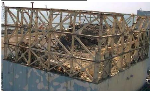
オペフロ全景（北西面）
