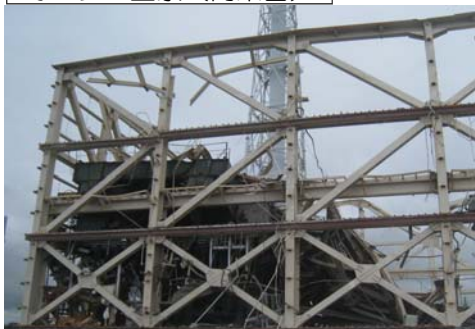
オペフロ全景（南東面）
