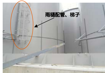
<J1エリアタンクおよび雨樋配管、梯子>
