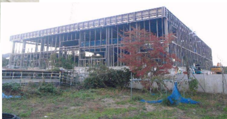
【現状】鉄骨工事他実施中
