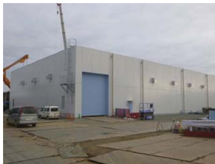
サブドレン浄化設備建屋全景
