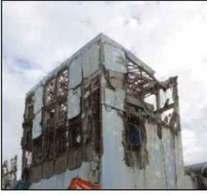
①原子炉建屋ガレキ撤去作業前
