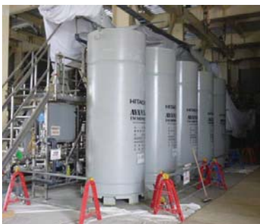
浄化設備（吸着塔）
