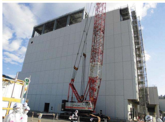
【現状】外壁工事实施中
