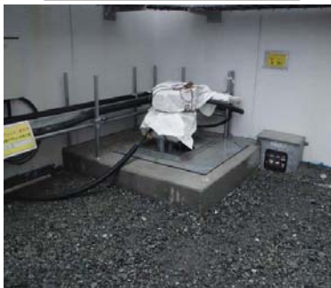
サブドレンピット
