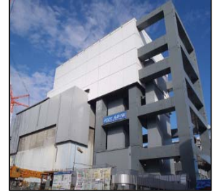
④燃料取り出し用カバー完成
