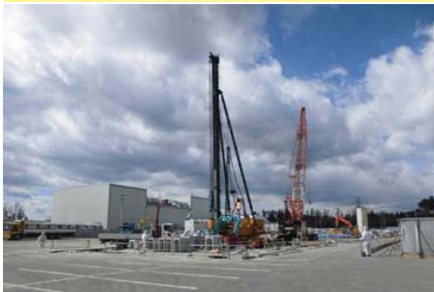
【前回公表時】基礎工事实施中
