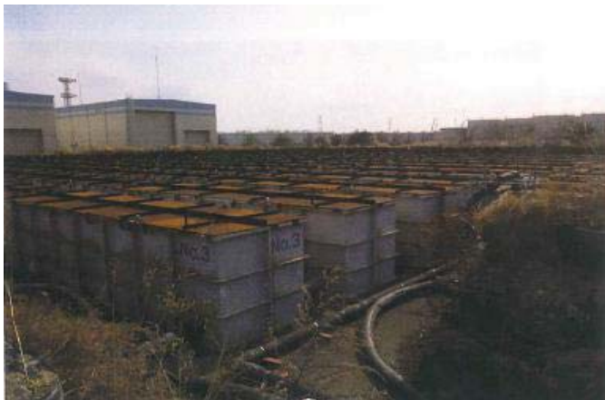
Dエリアノッチタンク撤去前
