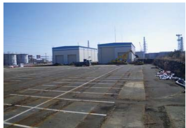
Dエリアノッチタンク撤去後
