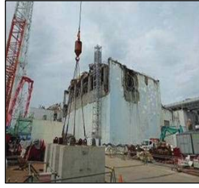
②原子炉建屋ガレキ撤去作業後
