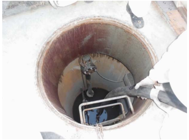
充填材打設状況
