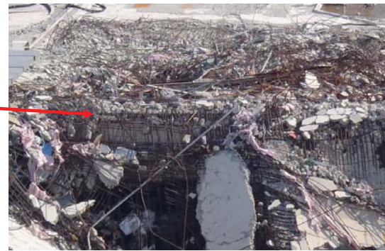
写真②北西崩落部拡大写真
