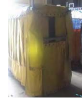
足場囲い型遮へい体
