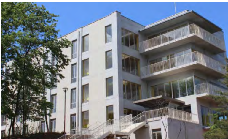
平成25年5月に竣工したばかりのうつくしまふくしま未来支援センター棟
