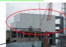
燃料取り出し用カバー
