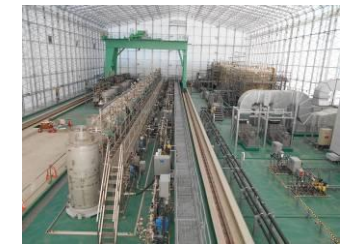
(高性能多核種除去設備の設置状況)
