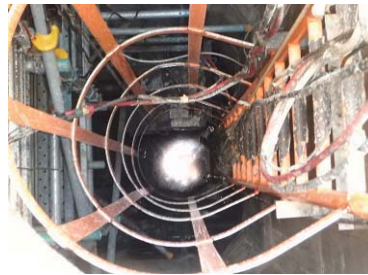
MH内部の状況
