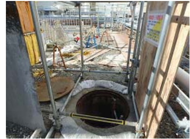
開口部Ⅱ MH開口状況
