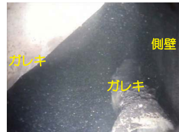
カメラ調査状況
