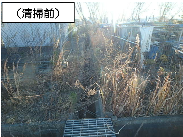
【写真①】危険物保管ヤード南西側溝
