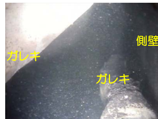
カメラ調査状況
