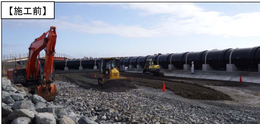
【写真①】4m盤アスファルト舗装施工状況(1～4号機放水口周辺)
