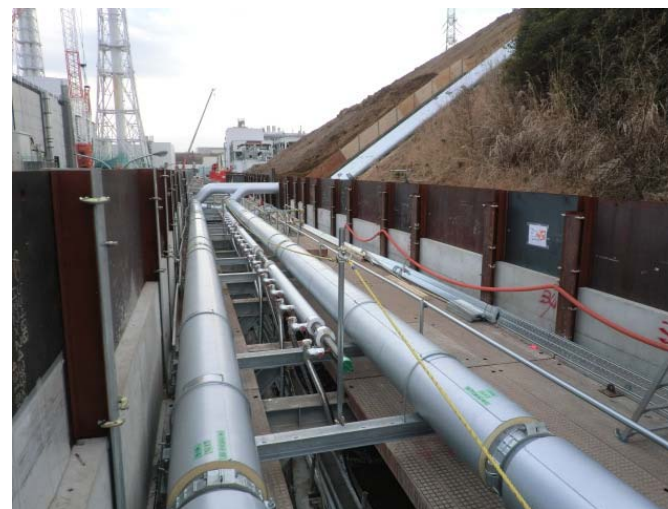
写真③：5BLKブライン配管設置状況
