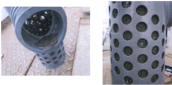
陸上ストレーナ詰まり状況
