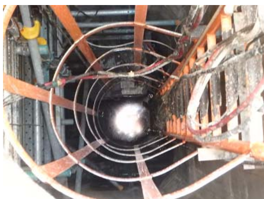
マンホール内部の状況
