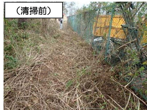
【写真③】固体廃棄物建屋北側側溝
