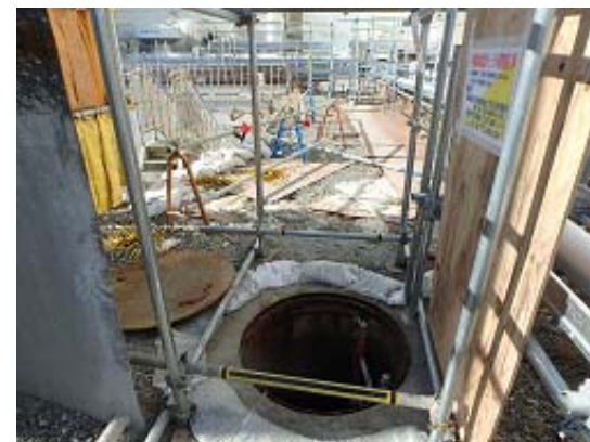
開口部Ⅱ マンホール開口状況
