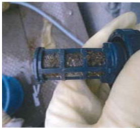
エアコンストレーナ詰まり状況
