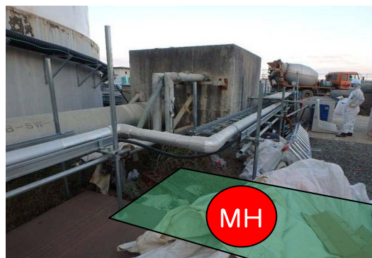
開口部Ⅱ 地上部状況 (着手前)
