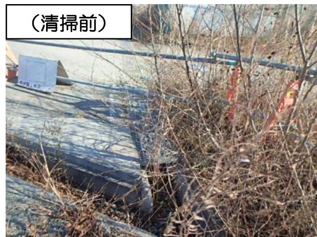
【写真②】危険物保管ヤード西側側溝
