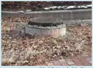
マンホール隆起や液状化の再現展示
