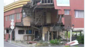
震災による建物破壊 (富岡駅前)
