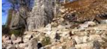
小峰城石垣崩落等
