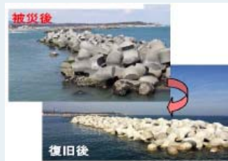
防波堤等の被災及び復旧状況
