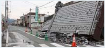
小高中心街液状化倒壊等
