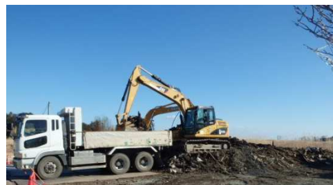
双葉町における 津波がれきの撤去状況 (平成27年1月)
