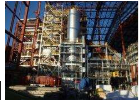
富岡町における仮設焼却施設の建設状況(平成27年1月)
