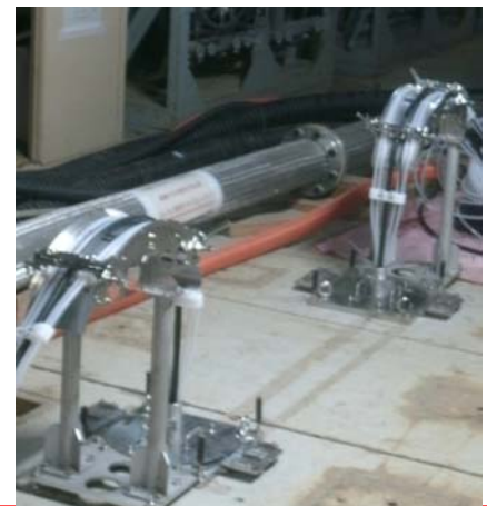
④Rw/B水位計の設置
