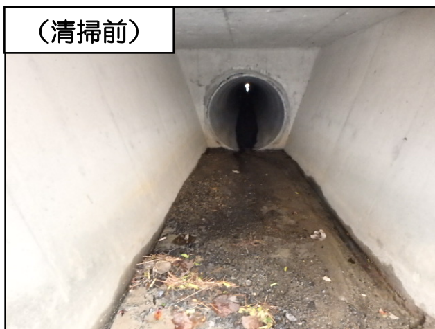
【写真②】固体廃棄物建屋東側水路
