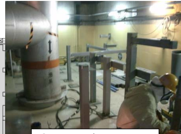
④配管サポート組立中
