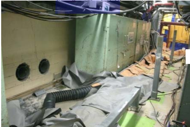
①配管サポート組立及びP E管敷設準備
