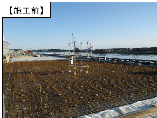
【写真①】4m盤フェーシング施工状況(1-2号機間海側)
