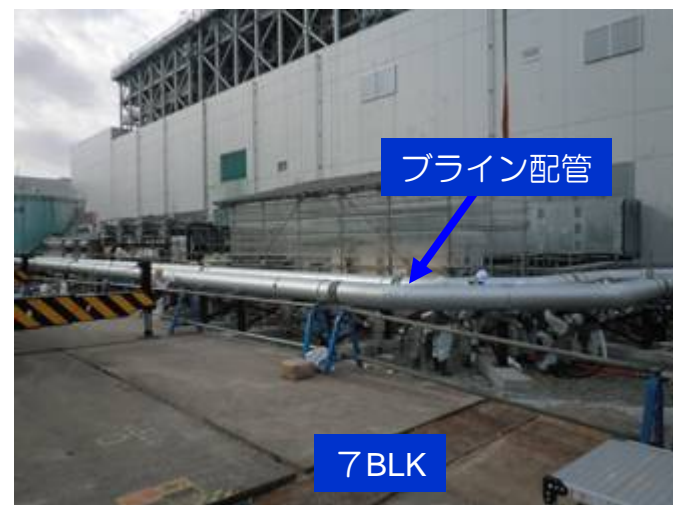
写真③：7BLKブライン配管設置状況
