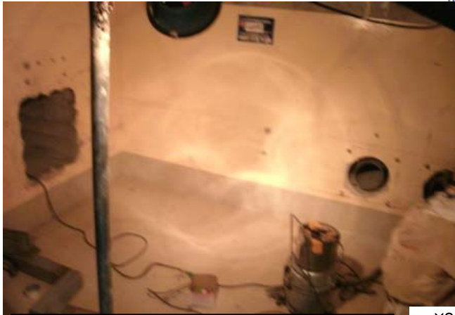
②穿孔完了及びP E管敷設準備
