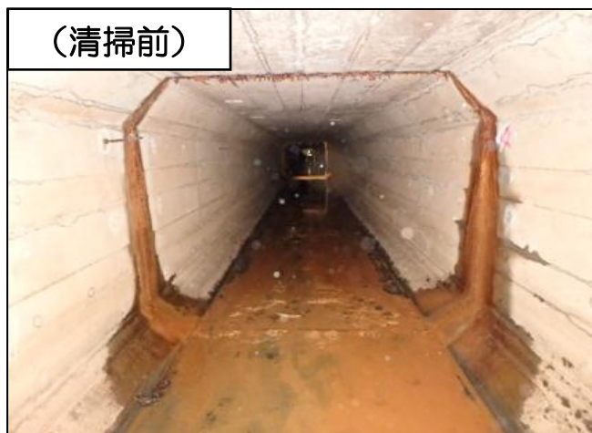
【写真①】A排水路暗渠 (6号西側)
