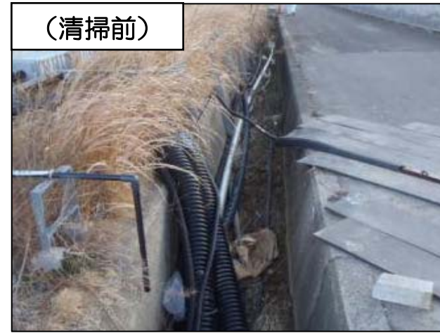
【写真③】免震重要棟南側側溝
