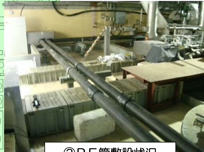
③P E管敷設状況
