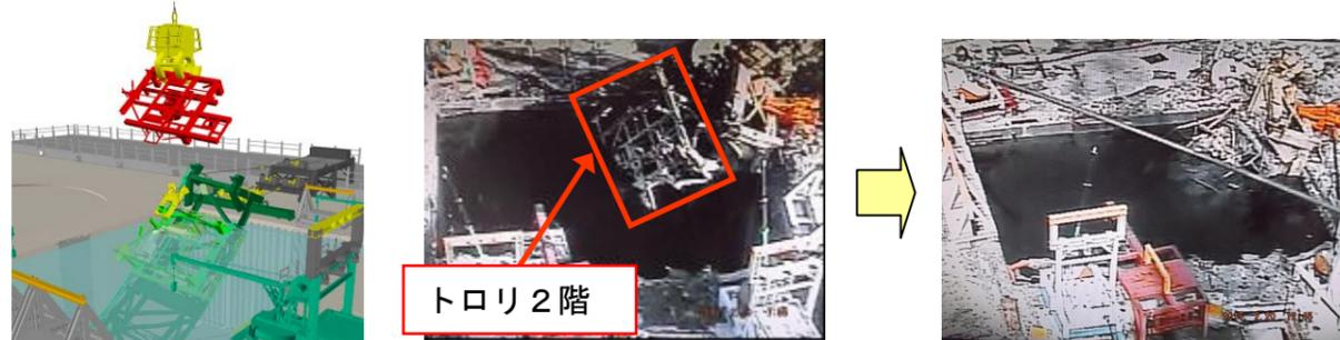
図8：3号機使用済燃料プールガレキ撤去状況
