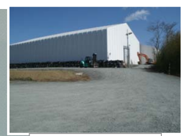
瓦礫保管テント
