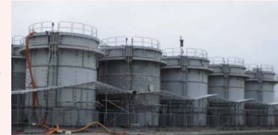
堰カバー設置後
