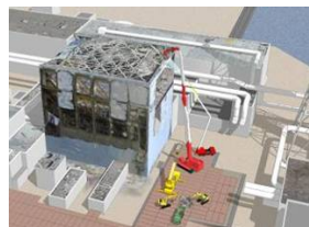
原子炉建屋上部のガレキ撤去
