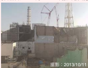
大型ガレキ撤去後
