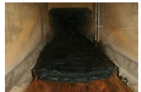
2/10撮影（K排水路）
