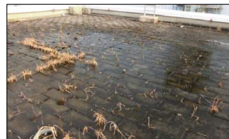
写真④：大物搬入口屋上
