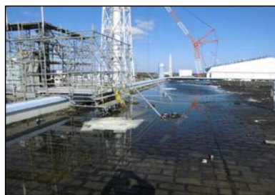
写真②：2号R/B屋上
