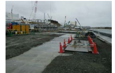
② 地表部処理完了箇所 (H27/2/19)
