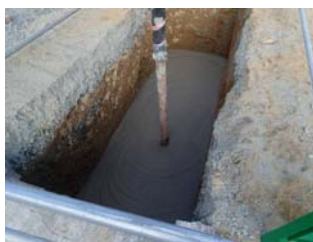
②モルタル置換施工
