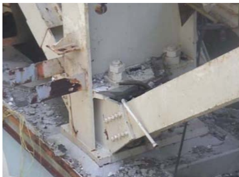
② 9a通り柱脚 健全
