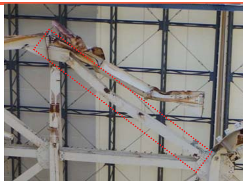
④ 9a-8a通り間上部鉄骨損傷
