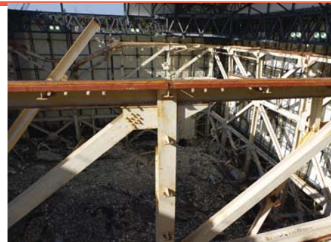
① 7a柱上部梁 健全
