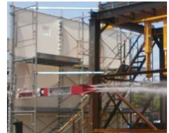
壁パネル外し前に壁パネルに孔をあけ、側面からガレキに飛散防止剤を散布
