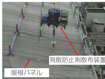
屋根パネルへの孔あけ状況
