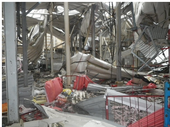
現状雨水流入対策が困難な場所 の例 1号Rw/B2階 屋根
