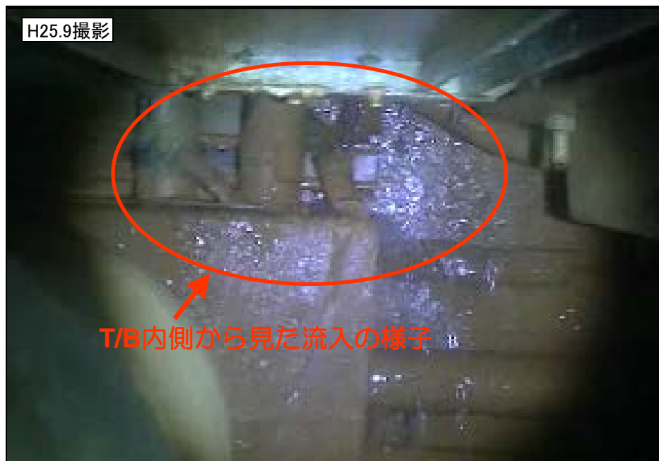
1号機 コントロールケーブルダクト からの地下水流入の様子
