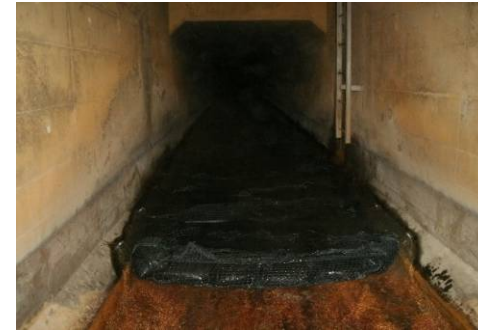
2/10撮影（K排水路）
