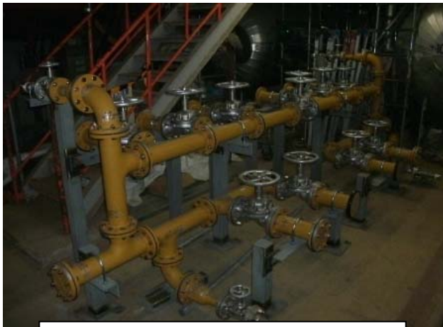
②鋼管ヘッダーの設置
