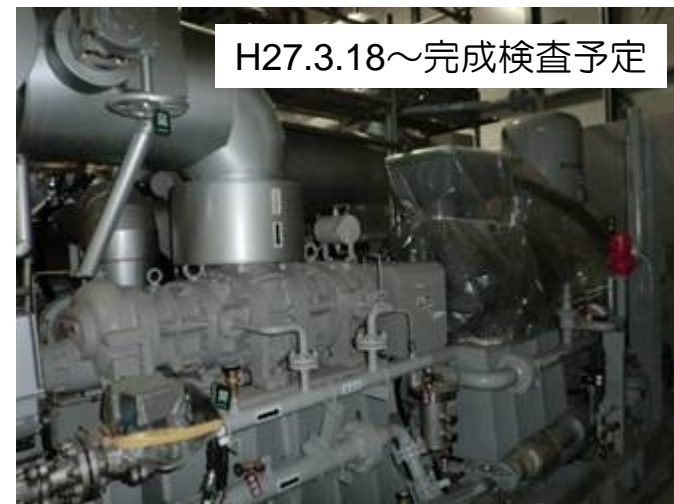
写真①：冷凍機 試運転完了(H27.3.7)
