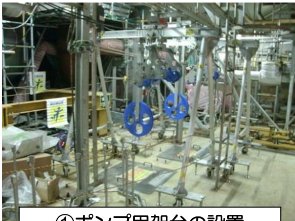
①ポンプ用架台の設置
