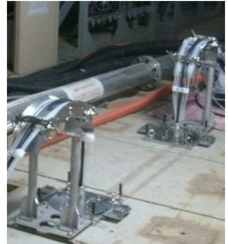
③Rw/B水位計の設置
