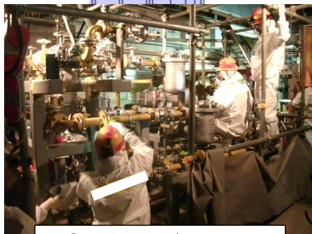
①鋼管ヘッダーの設置
