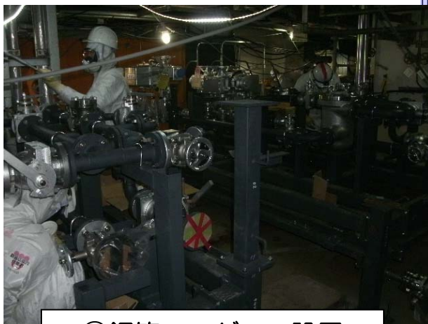
①鋼管ヘッダーの設置
