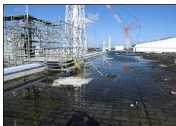
写真②: 2号R/B屋上
