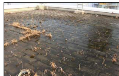
写真④: 大物搬入口屋上
