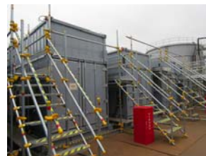
モバイル型 ストロンチウム除去装置
