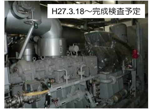
写真①：冷凍機 試運転完了(H27.3.7)
