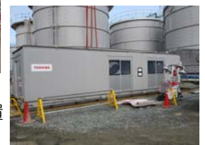
第二モバイル型 ストロンチウム除去装置
