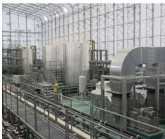
処理水タンク・供給タンクエリア
