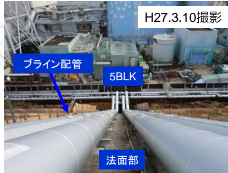
写真②：法面部ブライン配管設置状況
