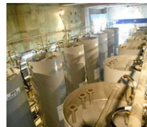
第二セシウム吸着装置吸着塔
