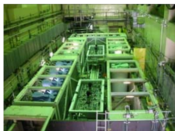
セシウム吸着装置吸着塔
